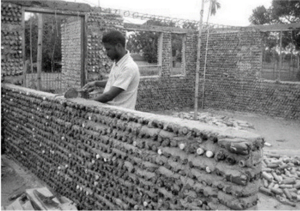
Gambar 5.4 Membangun Rumah dengan Ecobrick
