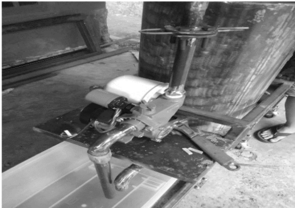
Gambar 7.15 Memasang Pompa Air
