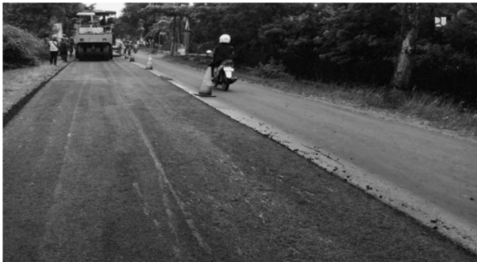
Gambar 5.3 Pengerasan Jalan dengan Aspal ( https://indonesia.go.id/kategori/indonesia-dalam-angka/922/tak-tembus-oleh-hujan-tak-retak-oleh-beban )
