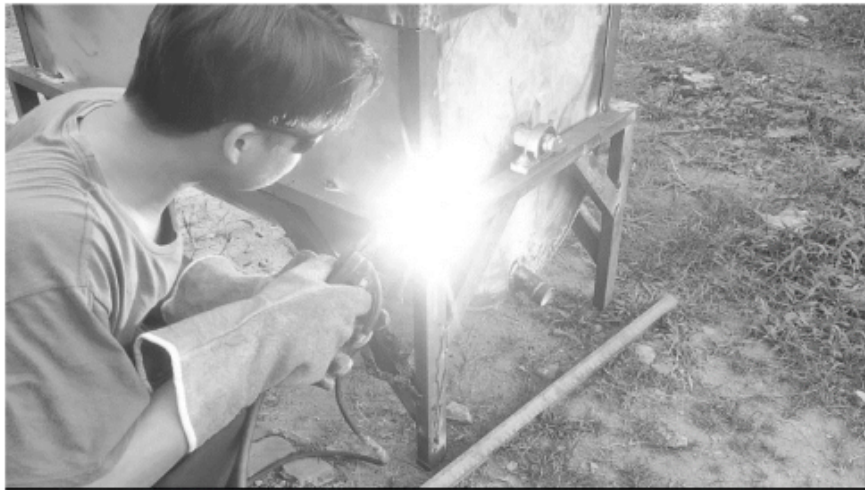
Gambar 7.23 Proses Pemasangan Wadah Bak Pencuci.
