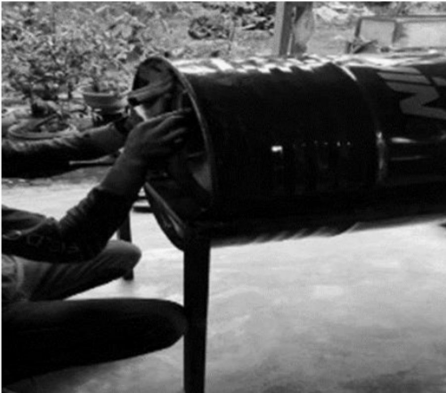
Gambar 7.33 Proses Penyambungan Rangka ke Drum Besi
