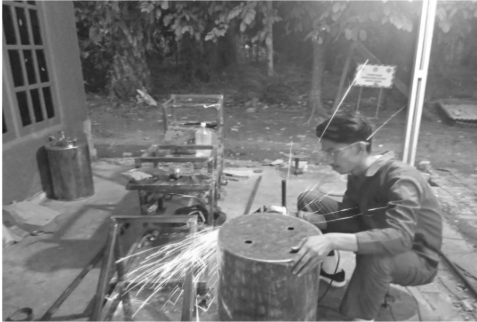
Gambar 7.14 Membuat Lubang Pada Kondensor
