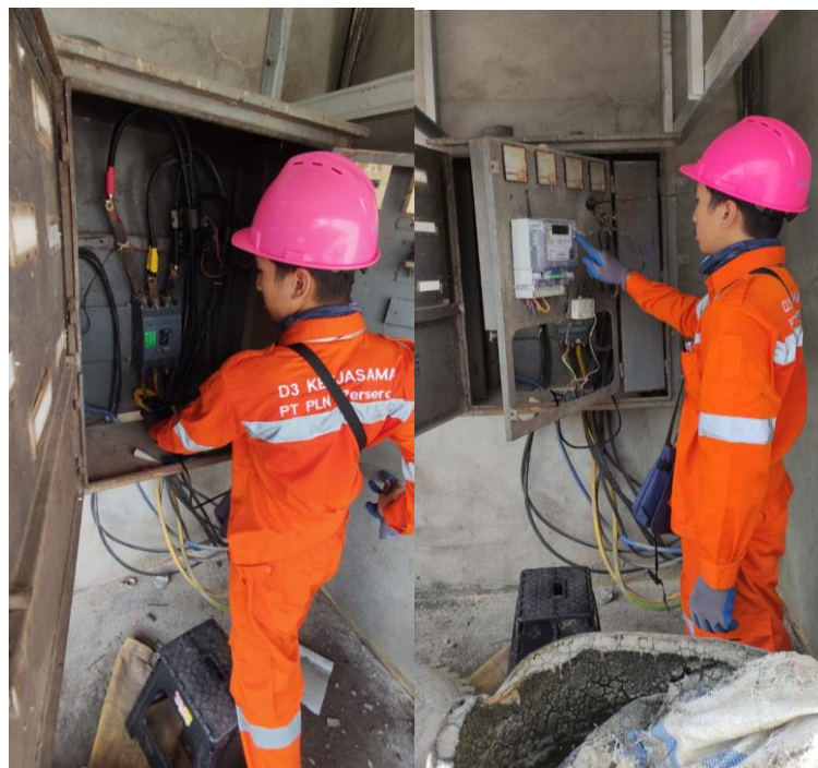
Lampiran 4 Gambar Proses Pengukuran Arus Beban Pelanggan
