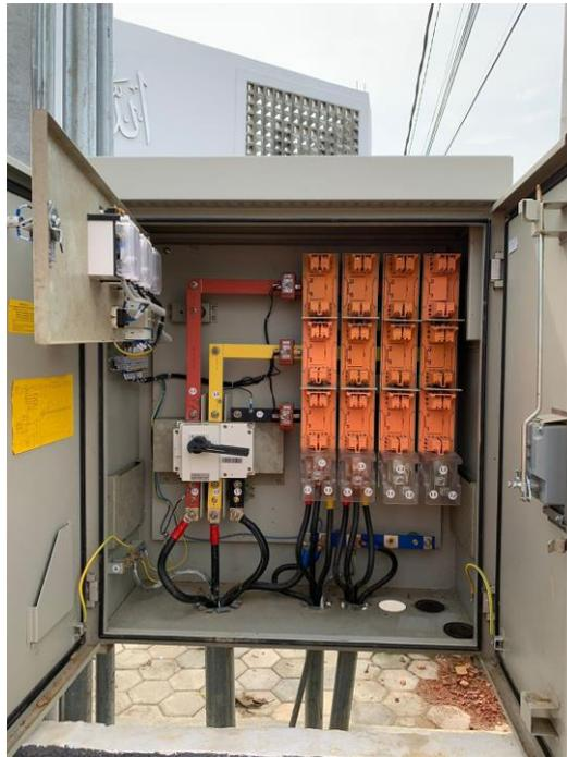
Gambar 2. 6 Panel Hubung Bagi Tegangan Rendah (PHB - TR)
