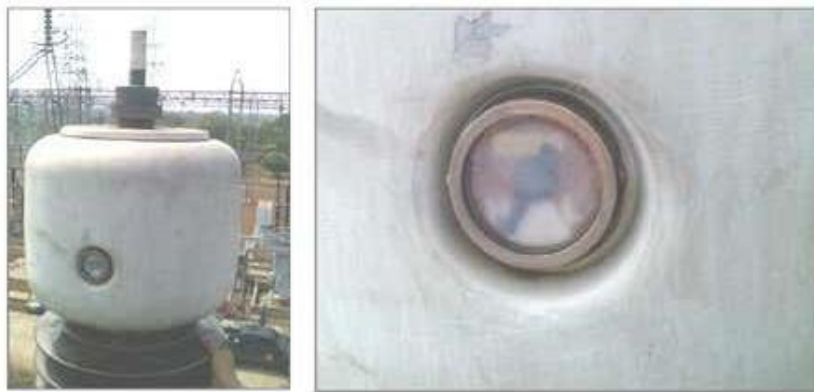
Gambar 2.8 Indikator Level Minyak Bushing
