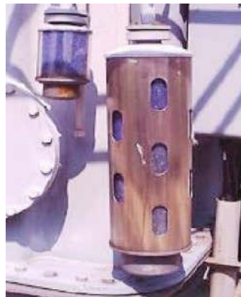
Gambar 2.13 Silica Gel
