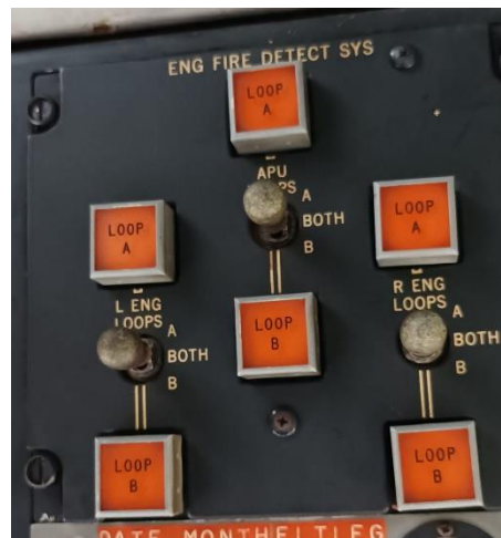
Gambar 2. 9 Panel sistem detektor kebakaran
