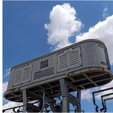
Gambar 2. 7 Tangki konsevator
