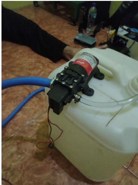
Pemasangan Pompa DC dan Selang pada Tanki Air
