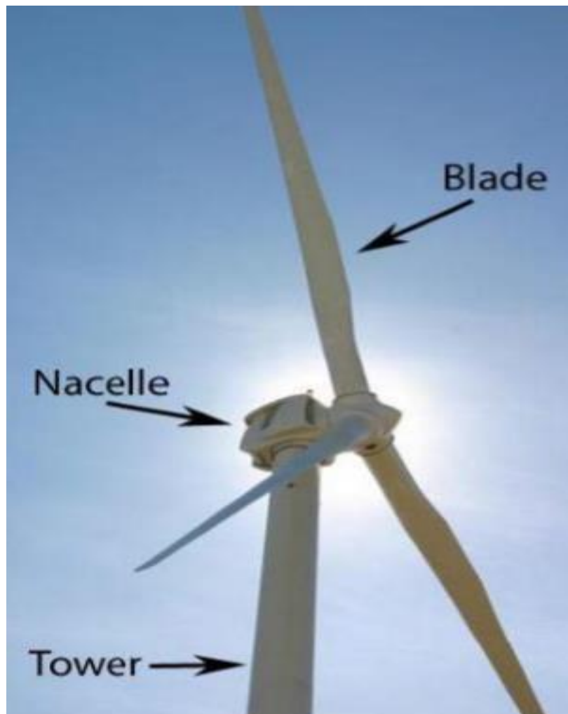
Gambar 2. 7 Komponen Wind Turbine Angin
