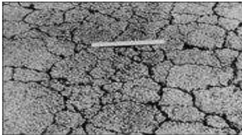
Gambar 2.4 Retak Kulit Buaya Tinggi
