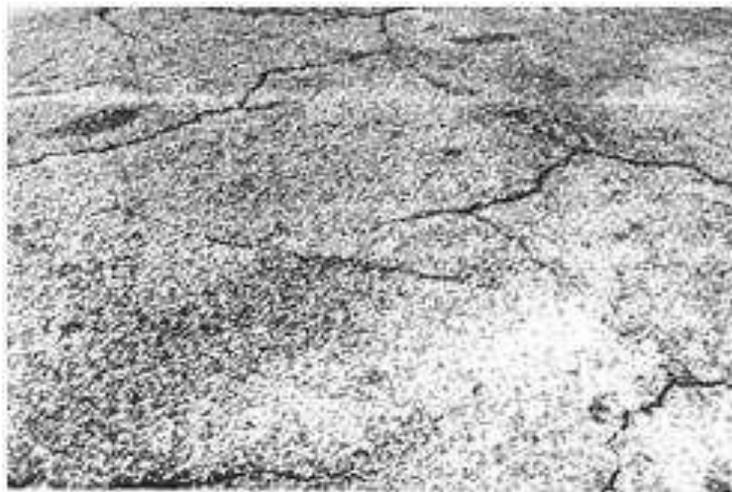
Gambar 2.10 Retak Blok Keparahan Tinggi
