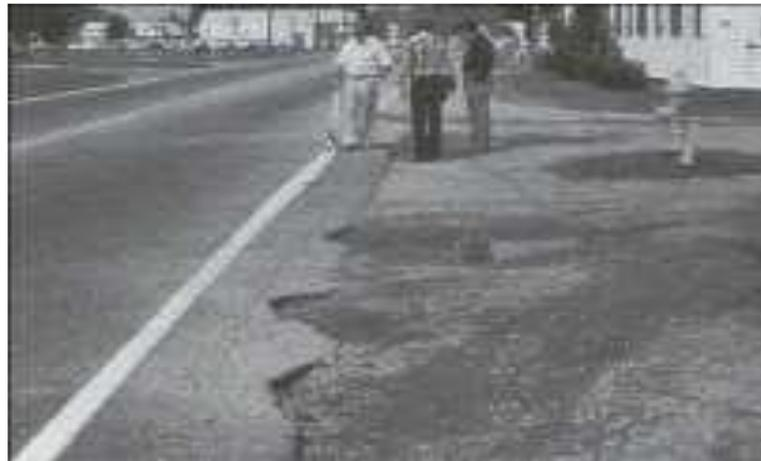
**Gambar 2.22** Retak Tepi Dengan Keparahan Tinggi
