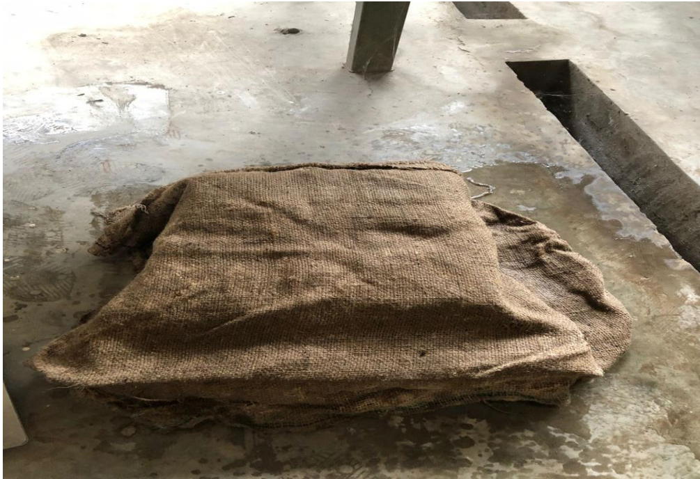
Gambar 49. Beton metode dengan menutupi menggunakan karung goni lembab/basah.
