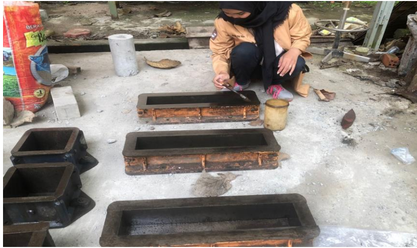
Gambar 37. Cetakan benda uji balok dioleskan oli sebelum dimasukkan campuran beton
