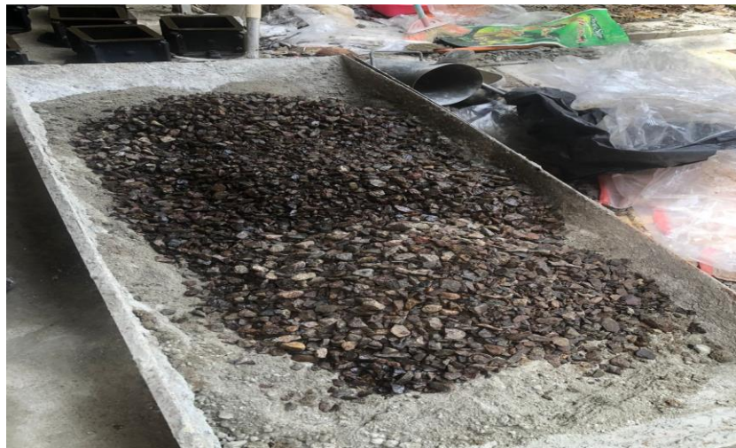
Gambar 34. Material di masukkan kedalam bak pengaduk
