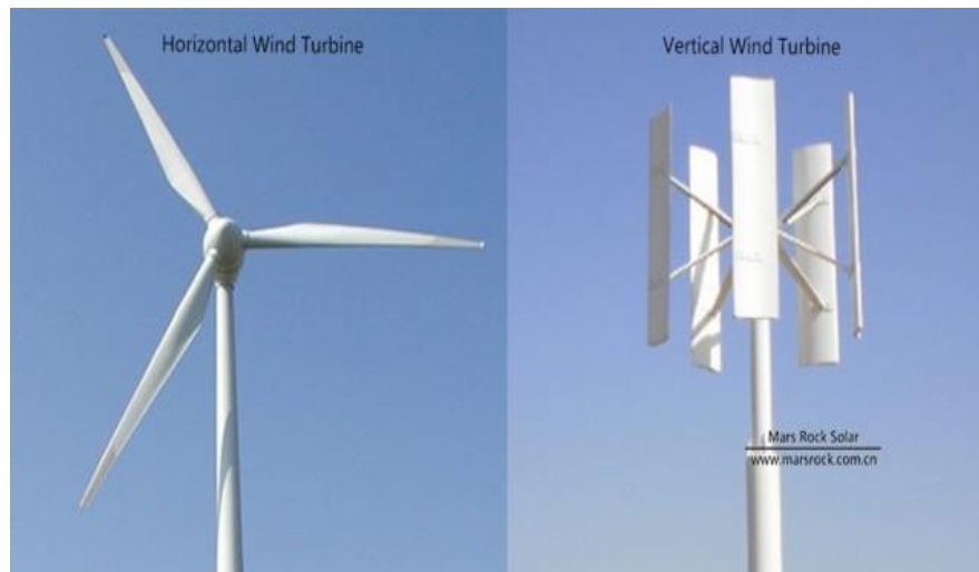
Gambar 2. 1 Turbin angin sumbu horizontal dan turbin angin sumbu vertikal (sumber: kejarcita.id)
