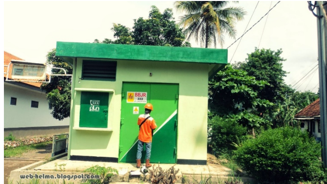
Gambar 2.12 Gardu Tipe Beton
