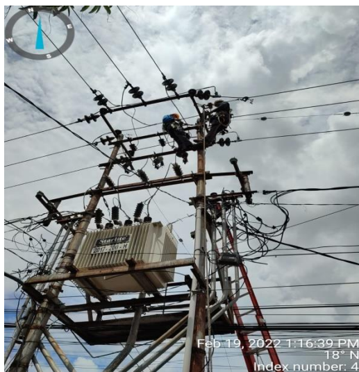
Pemasangan tutu bushing dan aptup
