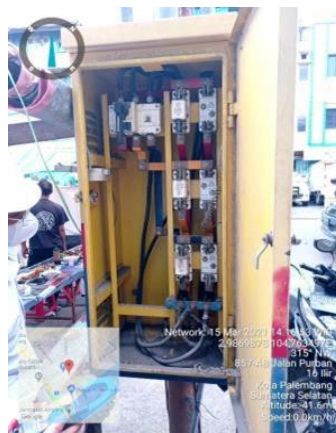
Gambar 2.7 Komponen PHB TR
