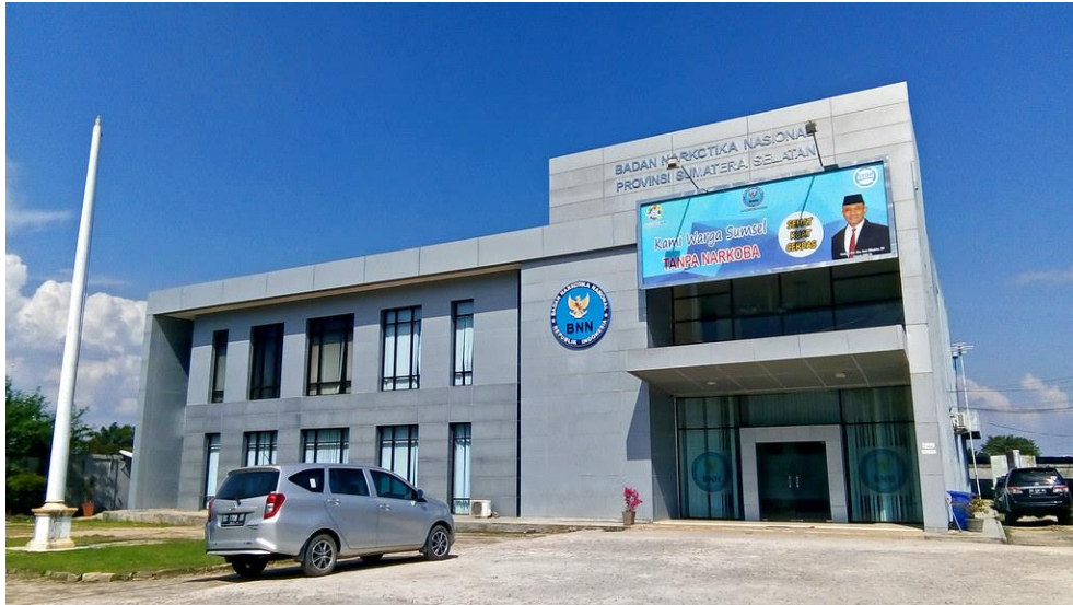
Gambar 2.1 Gedung BNN Sumsel
