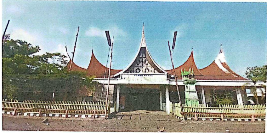
Rumah Makan Rantau Penantian Lahat Tampak Depan Sumber: Rumah Makan Rantau Penantian Lahat, 2023
