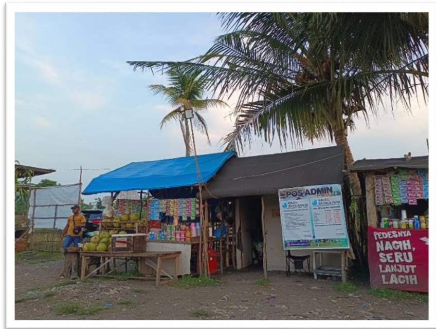
Gambar 4.16 Bangunan Ruang Admin/Pos Admin
