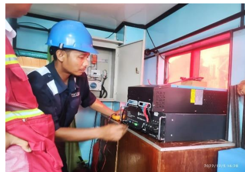
Penyambungan baterai dengan inverter
