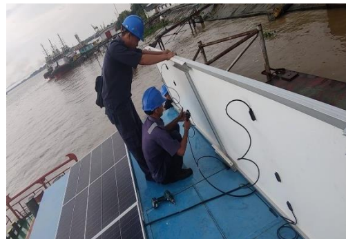
Pemasangan Solar Panel Ke Rangka
