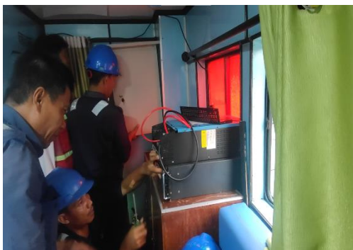
Pemasangan Box Panel dan Inverter
