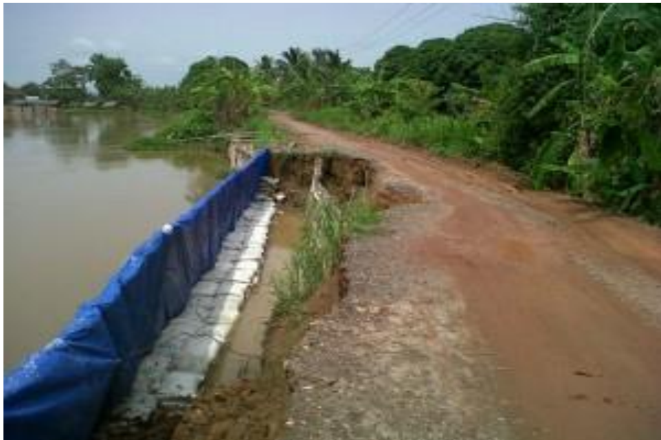
Gambar 1.1 Kondisi Jalan Longsor Desa Kamal Kec. Pamulutan, Ogan Ilir
