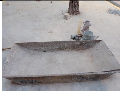
Plat Adukan Beton
