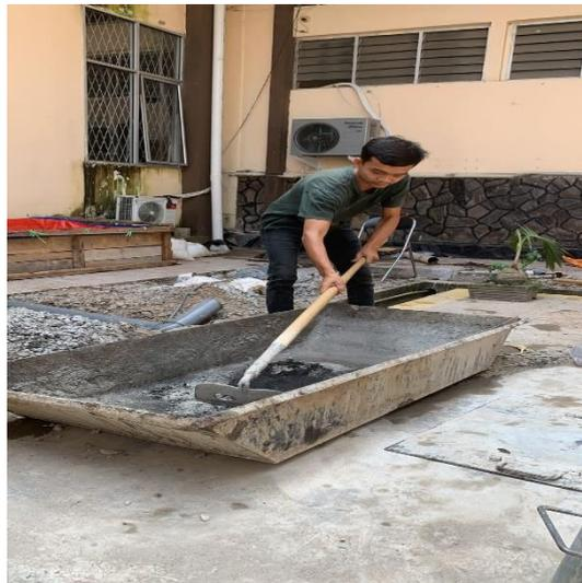
Gambar 3.5 Proses Pembuatan Adukan Beton.
