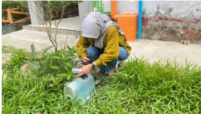
Gambar 1.25 Proses pencatatan pemakaian air di meteran air induk kantin
