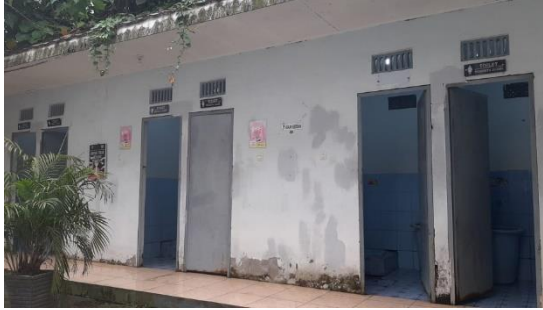
Gambar 1.1 Lokasi toilet perempuan (bak 3-8)
