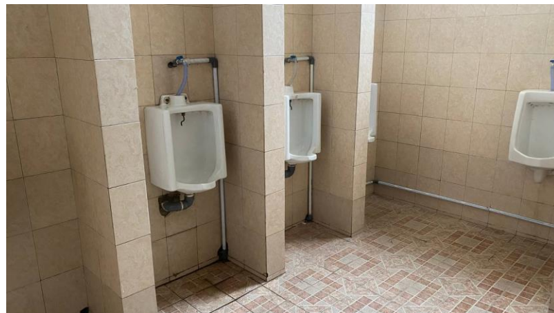
Gambar 1.10 Kondisi dalam toilet laki-laki
