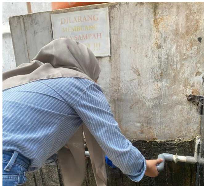
Gambar 1.24 Proses pencatatan pemakaian air di meteran air sambungan ruang guru
