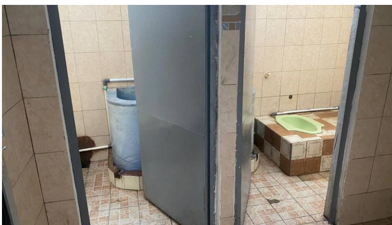
Gambar 1.11 Kondisi dalam toilet laki-laki
