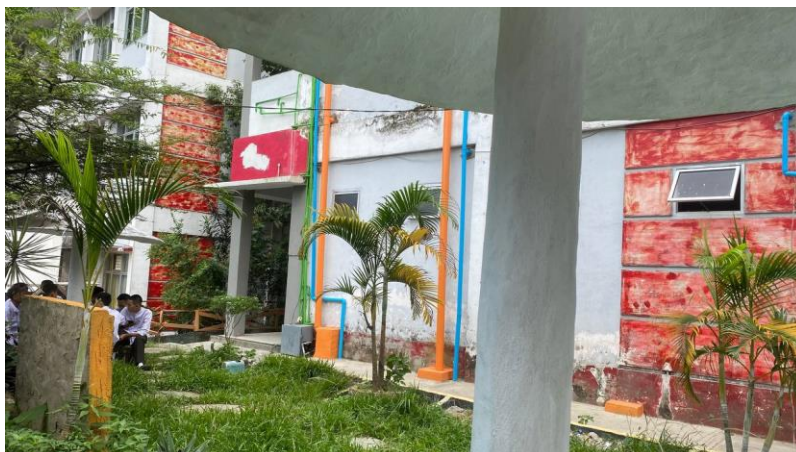
Gambar 1.14 Lokasi meteran air induk kantin
