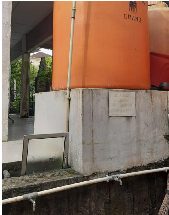
Gambar 1.8 Lokasi pemasangan meteran air sambungan ruang guru
