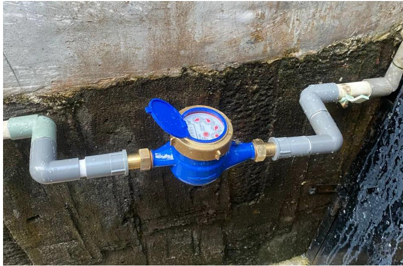
Gambar 1.18 Meteran air sambungan ruang guru setelah di pasang
