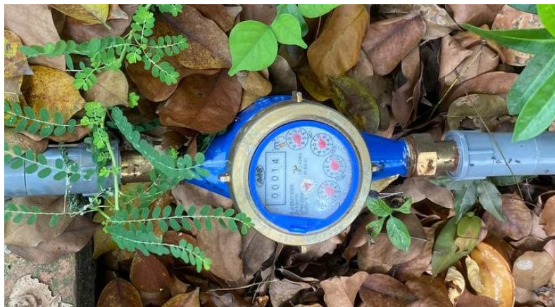
Gambar 1.19 Meteran air sambungan mushollah setelah di pasang
