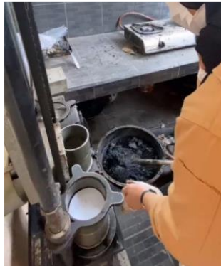
Gambar 17.7 Pemasukkan Campuran Aspal
