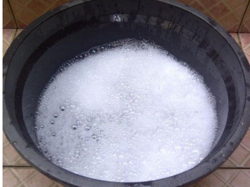
Pencampuran foam agent dengan air dengan perbandingan 1:30
