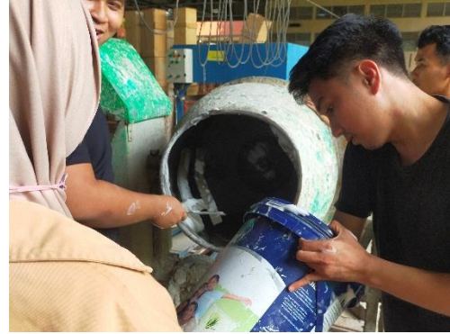
Proses pencampuran mortar dan busa
