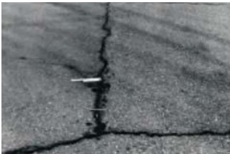
**Gambar 2.13** Retak Refleksi Sambungan (*joint reflection cracking*)
