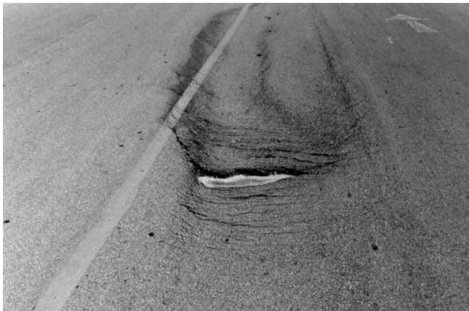
**Gambar 2.21** Retak selip (*slippage cracking*)
