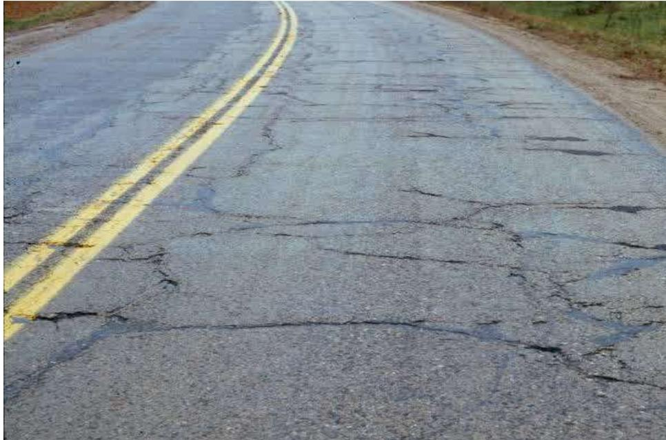
**Gambar 2.8** Retak Blok
