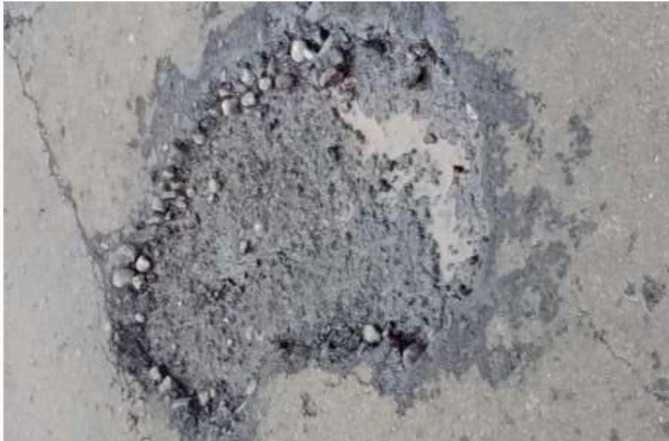
**Gambar 2.23** Pelepasan butir (*ravelling*)
