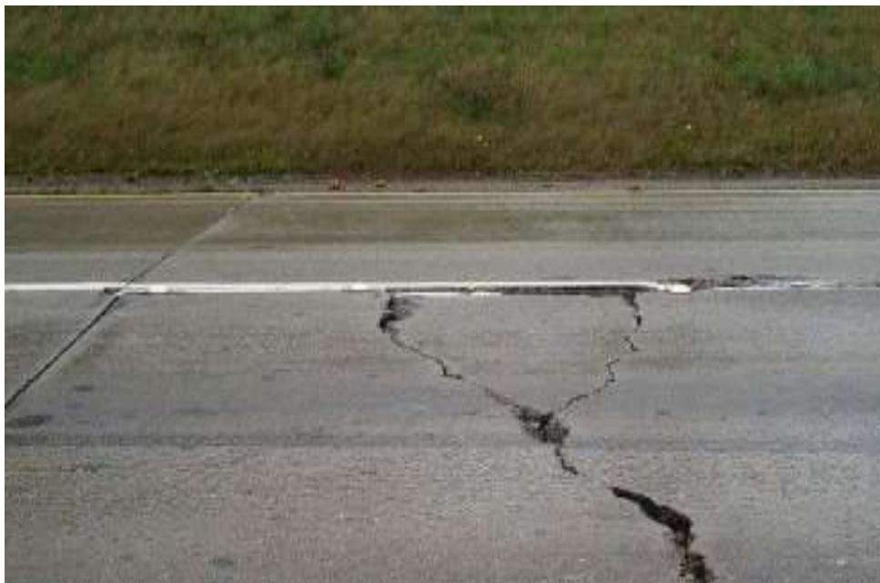
**Gambar 2.15** Retak Memanjang dan Melintang (bukan retak refleksi)
