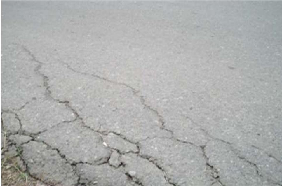
**Gambar 2.12** Retak tepi (*edge cracking*)
