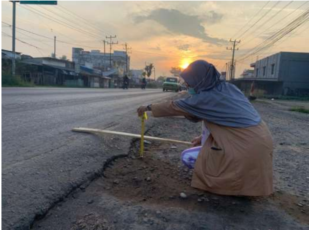
Gambar. Proses Pengukuran Dimensi Kerusakan
