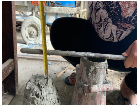
Pembacaan slump test
