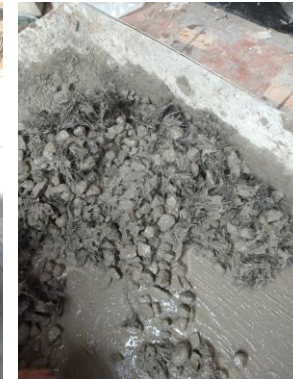
Pencampuran dan Pengadukan Beton
