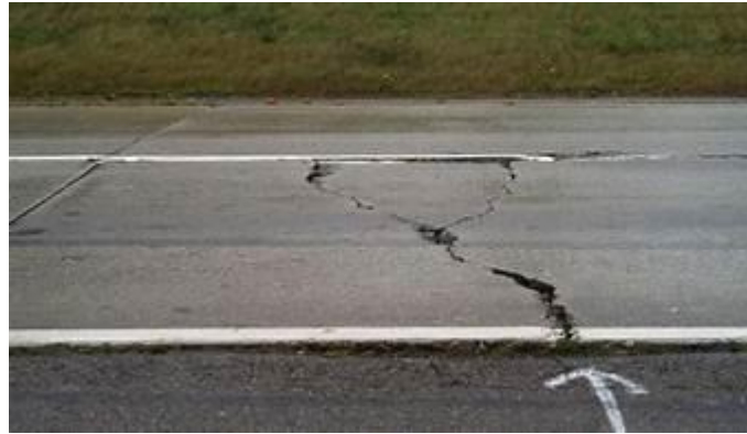
Gambar 2. 8 Retak Pinggir
