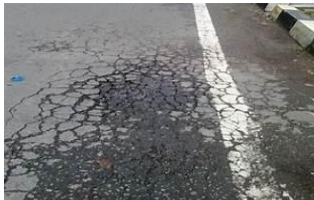
Gambar 2. 5 Retak ( Cracking )
