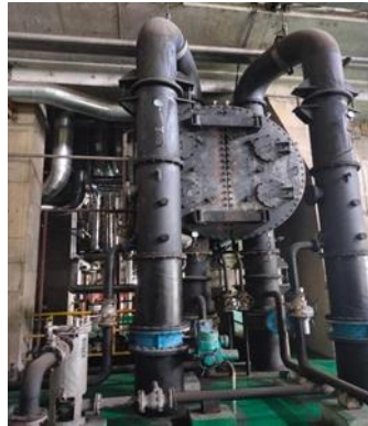
Gambar 2. 5 Kondensor PLTU TE 3X10 MW
