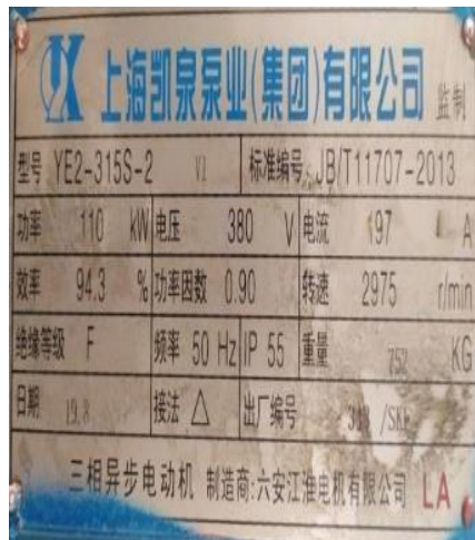
Gambar 2. 3 Speksifikasi motor intake PLTU TE 3x10 MW (PT. BEST, 2022)
