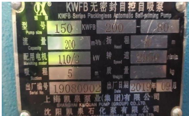
Gambar II.1 Spesifikasi Intake Pump
