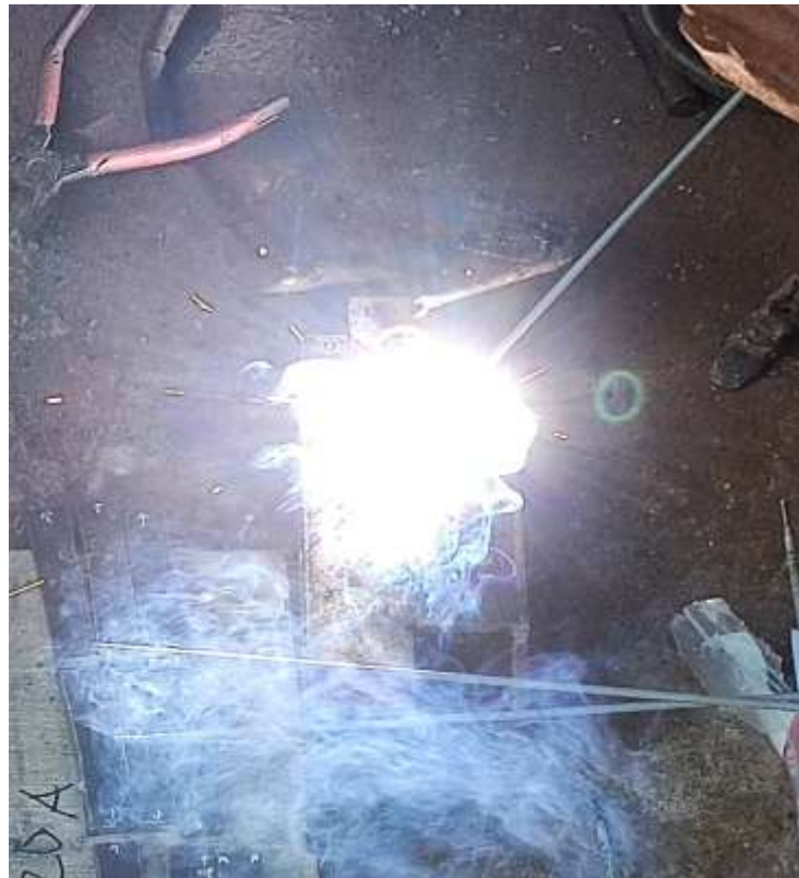
Proses pengelasan spesimen
