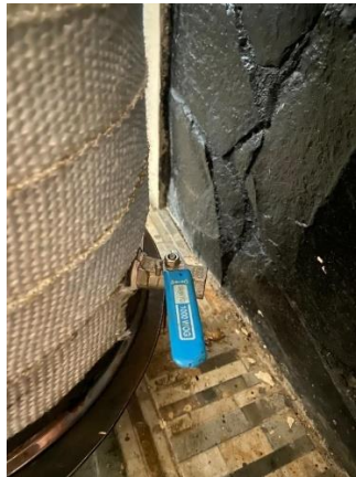
Gambar 2.6 Kran Pembuangan
