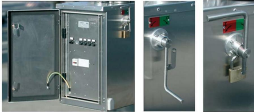
Gambar 2.3 Mekanik Penggerak PMS Manual
