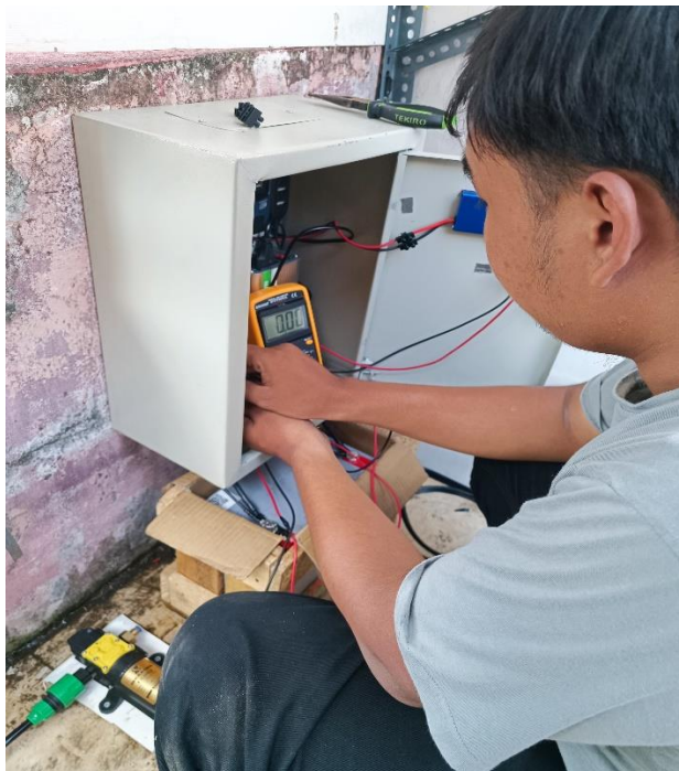
Perakitan Wiring Pada Box
