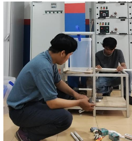
(d) Pemasangan Komponen Alat Simulasi
