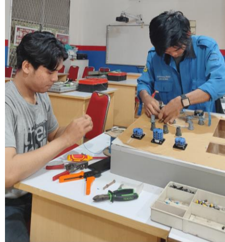
(b) Pengerjaan Kelistrikan Sistem Kontrol
