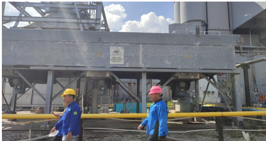
Gambar 2.10 Kipas Pendingin Oli unit 1 PLTG Borang
