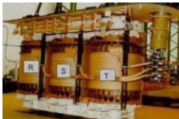
Gambar 2.4 Kumparan Transformator
