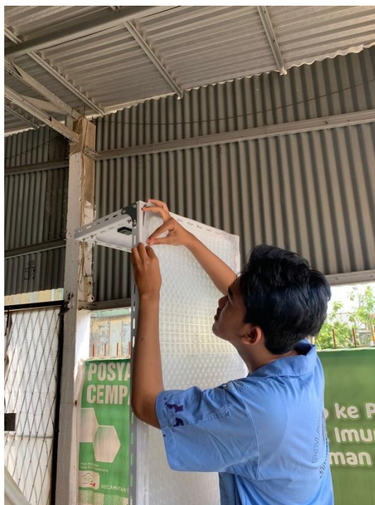
Foto Pemasangan Fiber Plastic di Bagian Belakang
