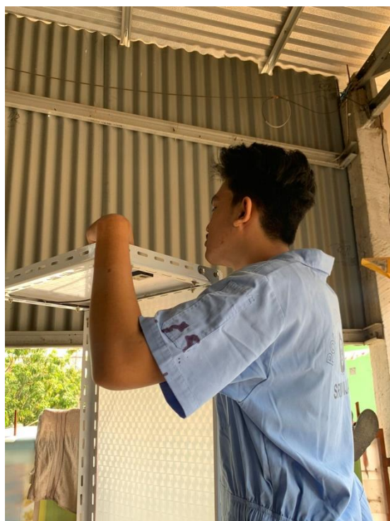
Foto Penyambungan Kabel Panel Surya
