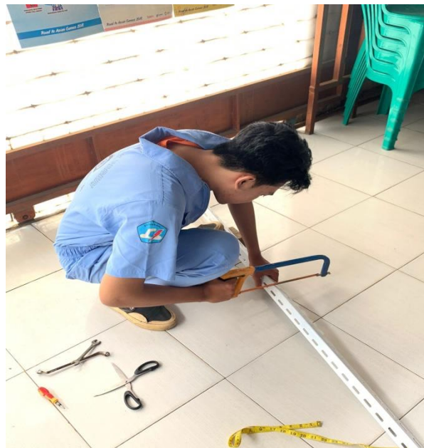
Foto Pemotongan Besi Siku
