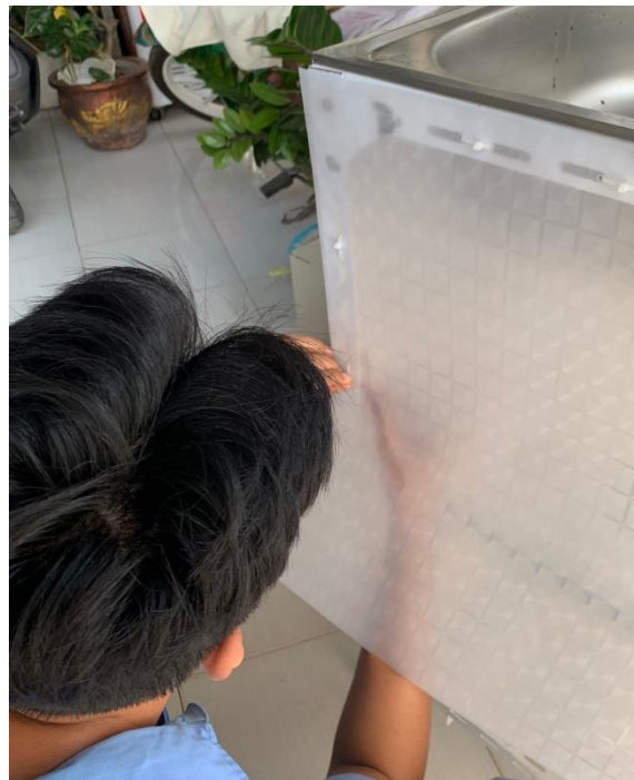
Foto Pemasangan Fiber Plastik
