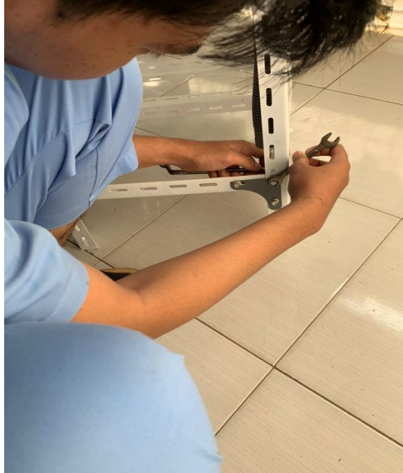
Foto Pengencangan Baut Rangka
