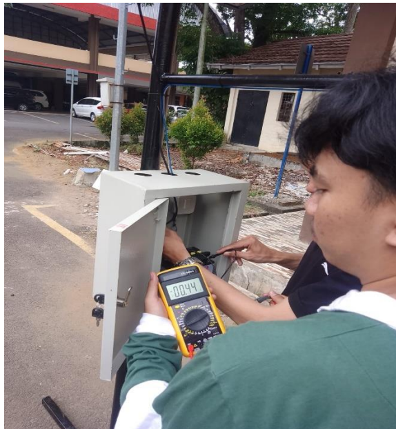
Mengukur Arus masukan pada baterai
