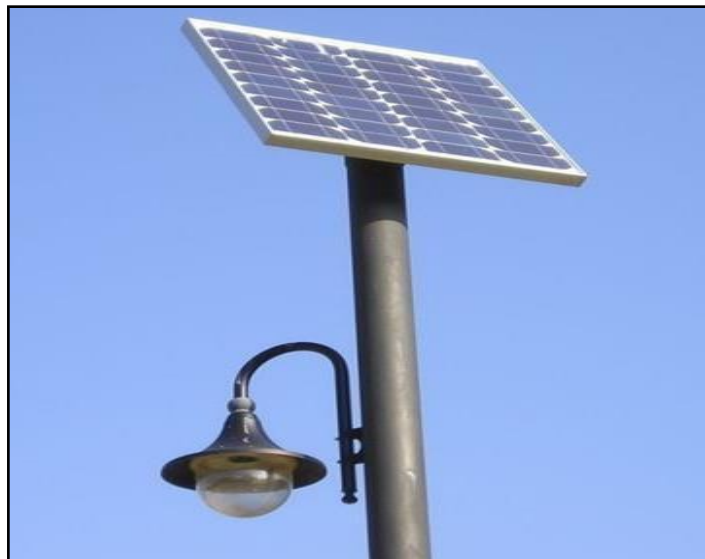
Gambar 2.9 Penerangan Jalan Umum Tenaga Surya (PJUTS)
