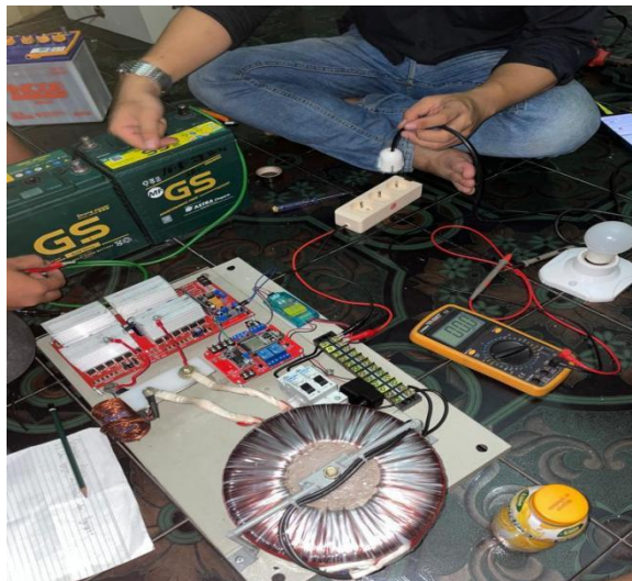
Ket :Pengujian Tegangan Sumber Tegangan Aki
