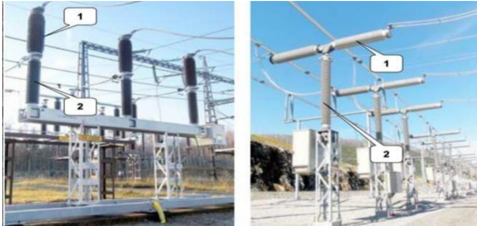
Gambar 2.9 Isolator pada Interrupting Chamber dan Support [6]
