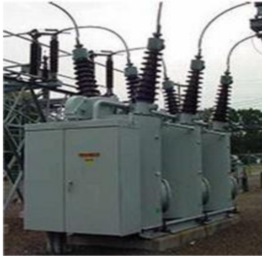
Gambar 2.3 PMT minyak [2]
