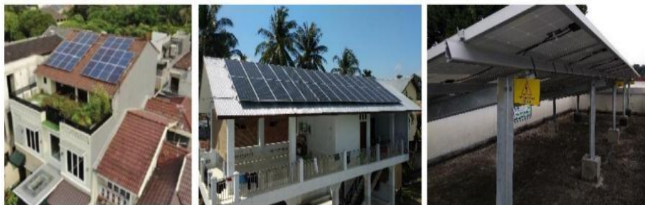
Gambar 2.5 Pemasangan PLTS diatas atap
