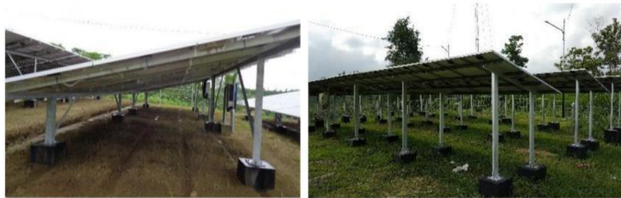
Gambar 2.4 Pemasangan PLTS dipermukaan tanah
