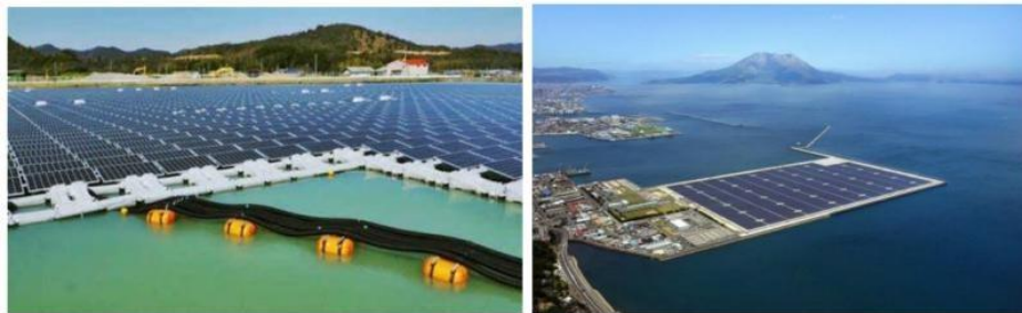
Gambar 2.6 Pemasangan PLTS Terapung
