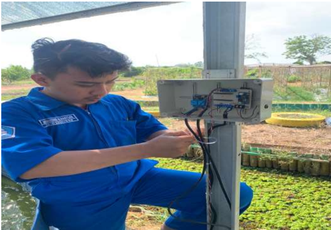
Keterangan : Proses Instalasi Box PCB
