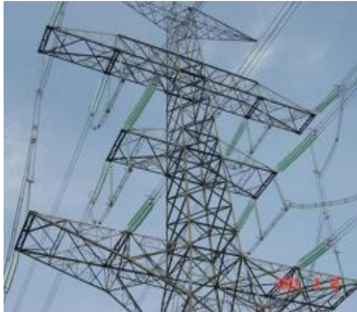
Gambar 2.4 Tiang Transposisi
