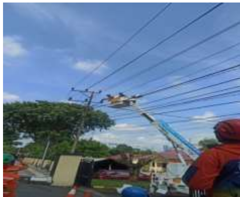
Kegiatan Penggantian Isolator yang Dilakukan oleh Team PDKP
