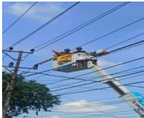
Kegiatan Penggantian Isolator yang Dilakukan oleh Team PDKP
