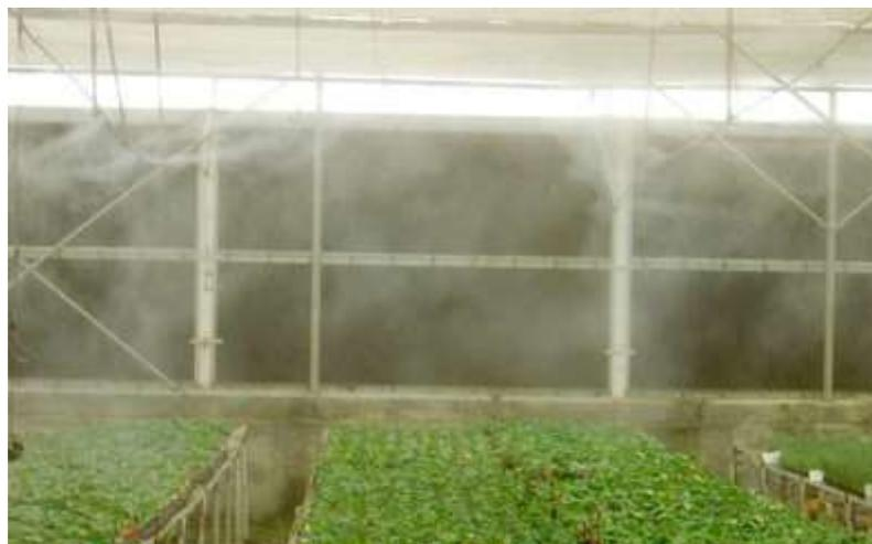
**Gambar 2.2** Sistem *Water Fogging* pada *Greenhouse*
