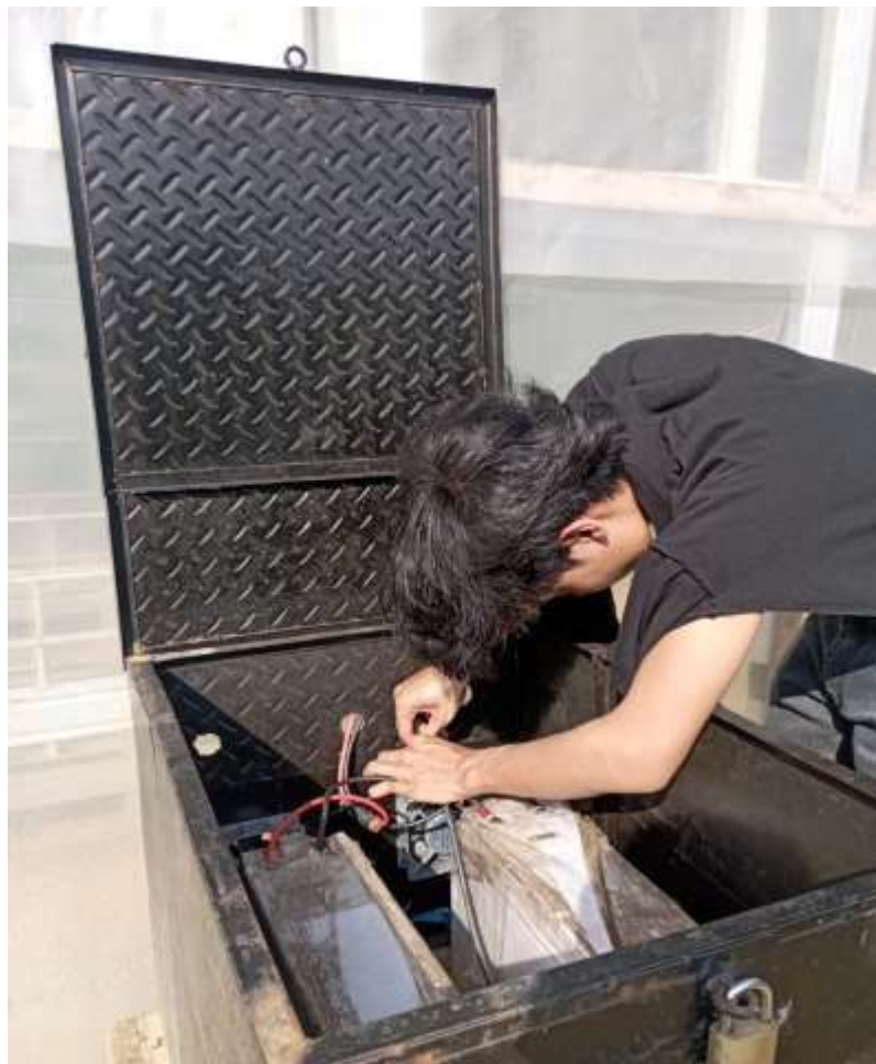
Pemasangan baterai aki
