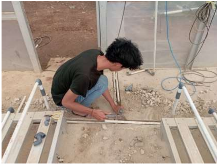
Pembuatan Jalur Pipa
